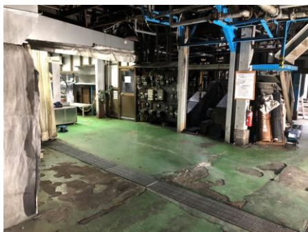
パネル施工前
