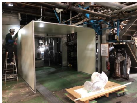
パネル施工後
