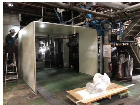
パネル施工後
