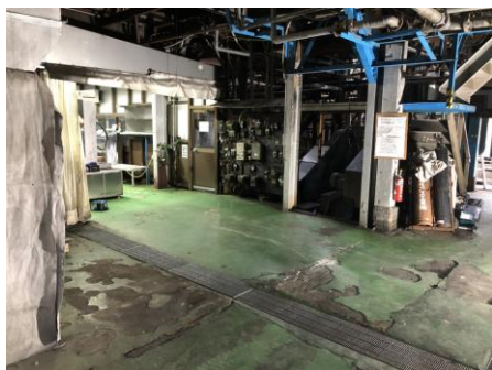
パネル施工前
